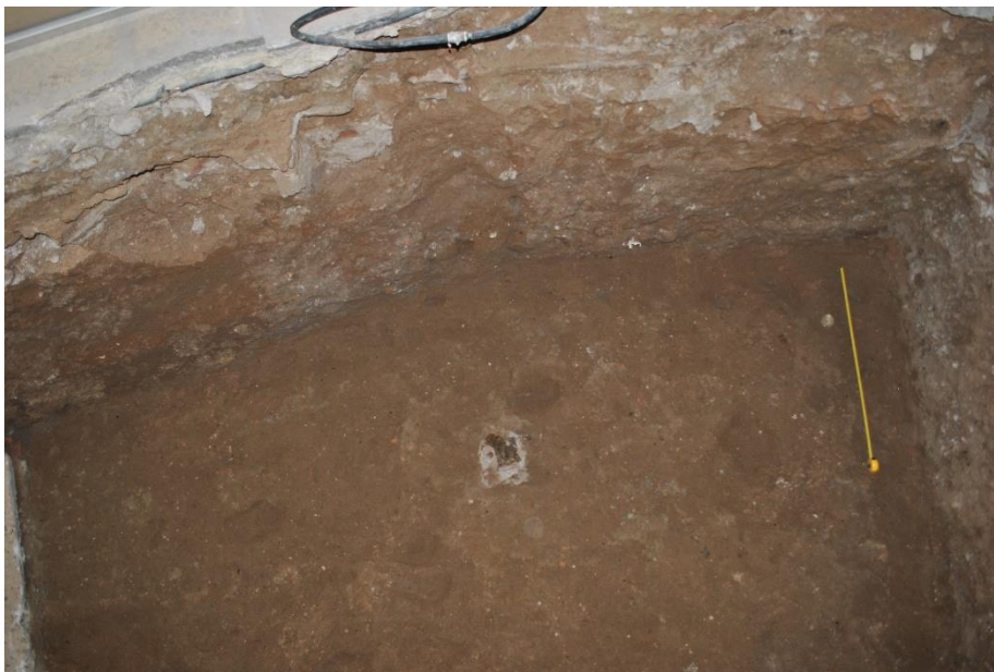
Fig 3.- Inici de l'excavació fotografiat des del Sud. Al centre de la imatge es pot apreciar les restes d'un pilar de fonamentació de l'antic soterrani.
